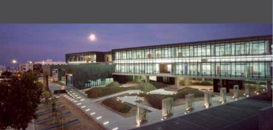
ΚΑΤΗΓΟΡΙΑ Α – Αξιόλογο Αρχιτεκτονικό Έργο Γραφεία Αρχής Ηλεκτρισμού Κύπρου στην Πάφο | Αρχιτέκτονας: Ηρακλής Παπαχρίστου
